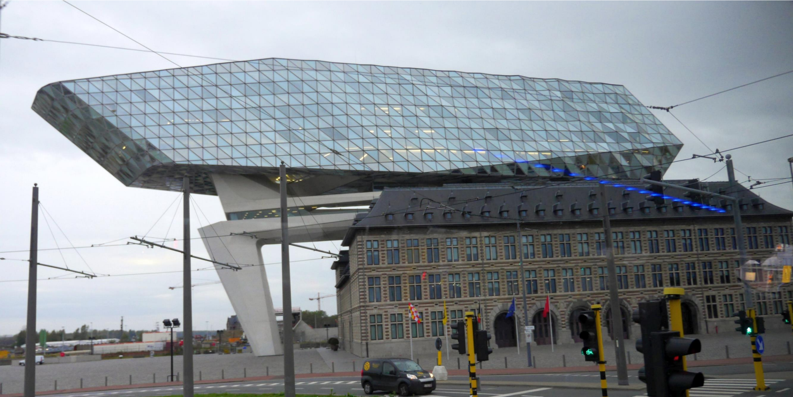
En als laatste een blik over de schouder op het Havenhuis, een werk van Zaha Hadid.
